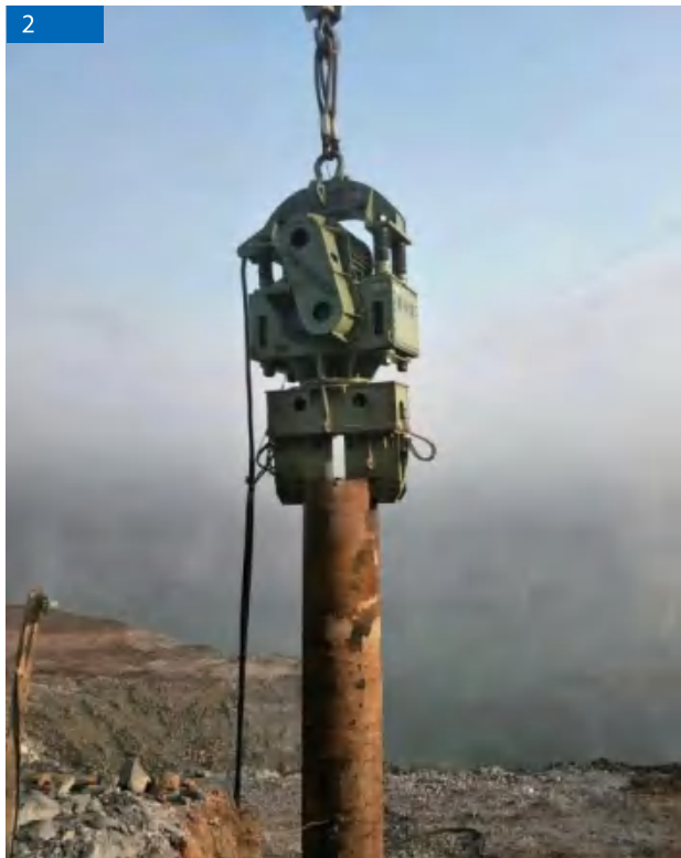
DZJ-120 2 湖南怀化张吉怀铁路 Zhangjihuai Railway,Huaihua,Hunan 使用单位：中铁大桥局第三公司 User: China Major Railway Bridge Engineering 3th Bureau 施工情况：桩径820mm Construction situation: 820mm diameter pipe pile 入土深度：20m Depth of penetration: 20m 地质情况：土砂 Geological conditions: Soil sand
