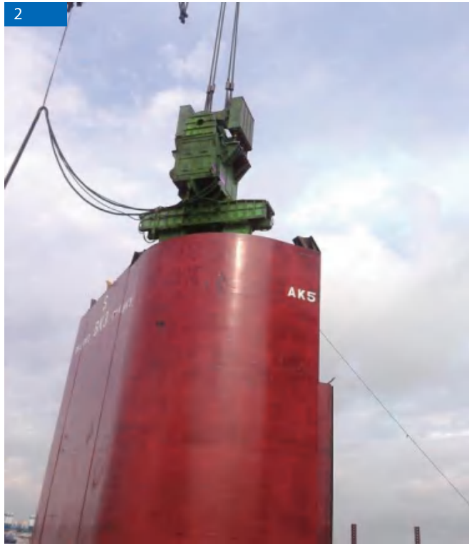
DZJ-135 1 海口文明东越江工程 Haikou Civilization East Yuejiang Construction 使用单位：上海韵勤建筑工程公司 User: Shanghai Yunqin Construction Engineering Co.,Ltd 施工情况：钢板桩 Construction situation: Steel sheet pile 入土深度：20m Depth of penetration: 20m
