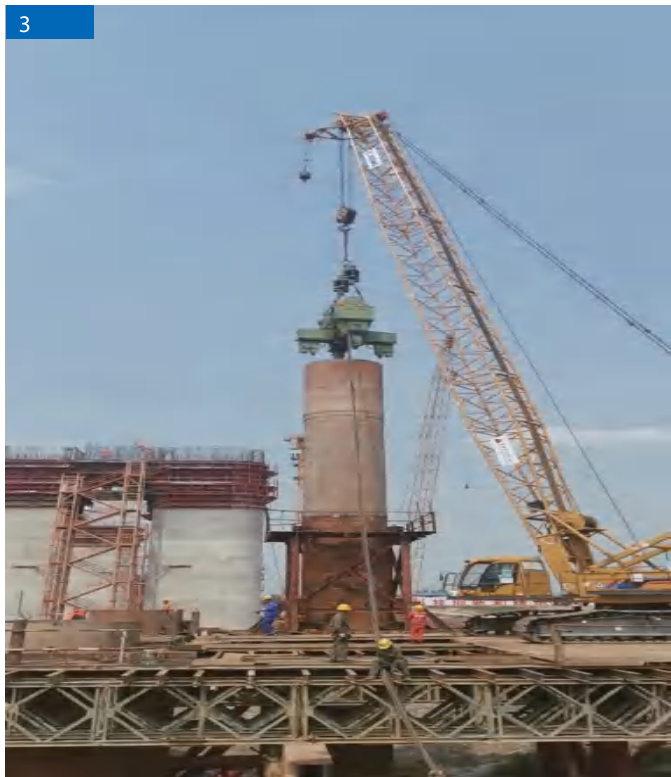
DZJ-120 2 湖南怀化张吉怀铁路 Zhangjihuai Railway,Huaihua,Hunan 使用单位：中铁大桥局第三公司 User: China Major Railway Bridge Engineering 3th Bureau 施工情况：桩径820mm Construction situation: 820mm diameter pipe pile 入土深度：20m Depth of penetration: 20m 地质情况：土砂 Geological conditions: Soil sand
